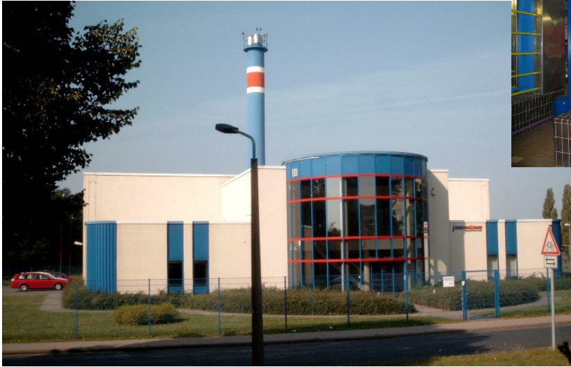
Heizwerk Neustadt-Glewe (MV) mit Innenansicht-Wärmetauscher
