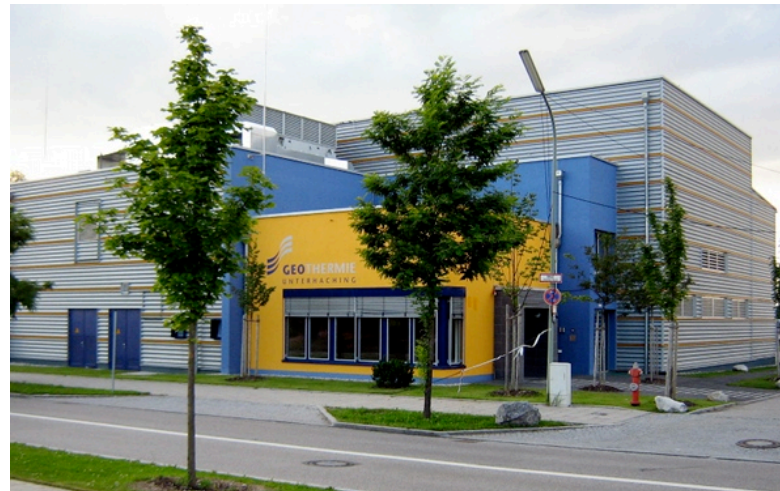
Heizwerk Unterhaching (Bayern)
